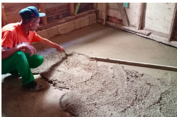
Sustitución de suelos de tierra por suelos de cemento en viviendas vulnerables
