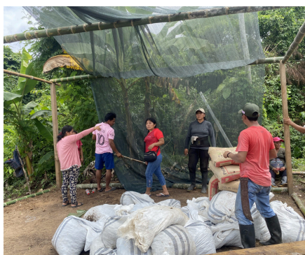
Construcción de vivero comunitario
